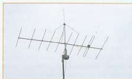
Een GP op de juiste wijze geplaatst, vrij van obstakels, bovenin de mast.
